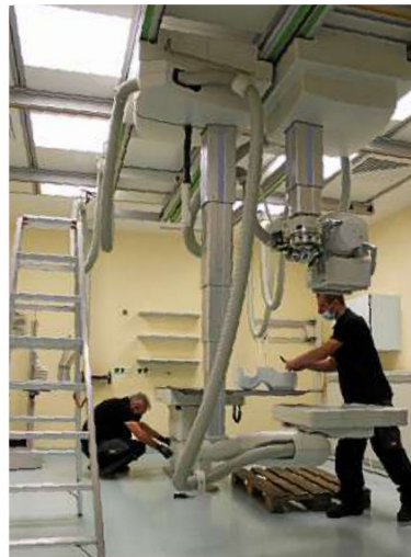
Mitarbeiter der Firma Hägele deinstallieren das zu ersetzende Röntgengerät. FOTO: UWE KOCH / RKK
